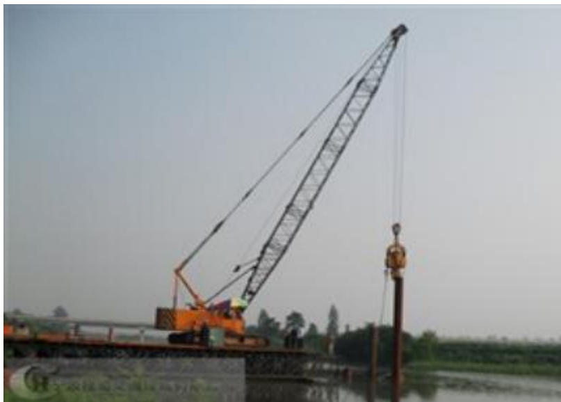
图 2.3-2 钢管桩沉桩示意图
