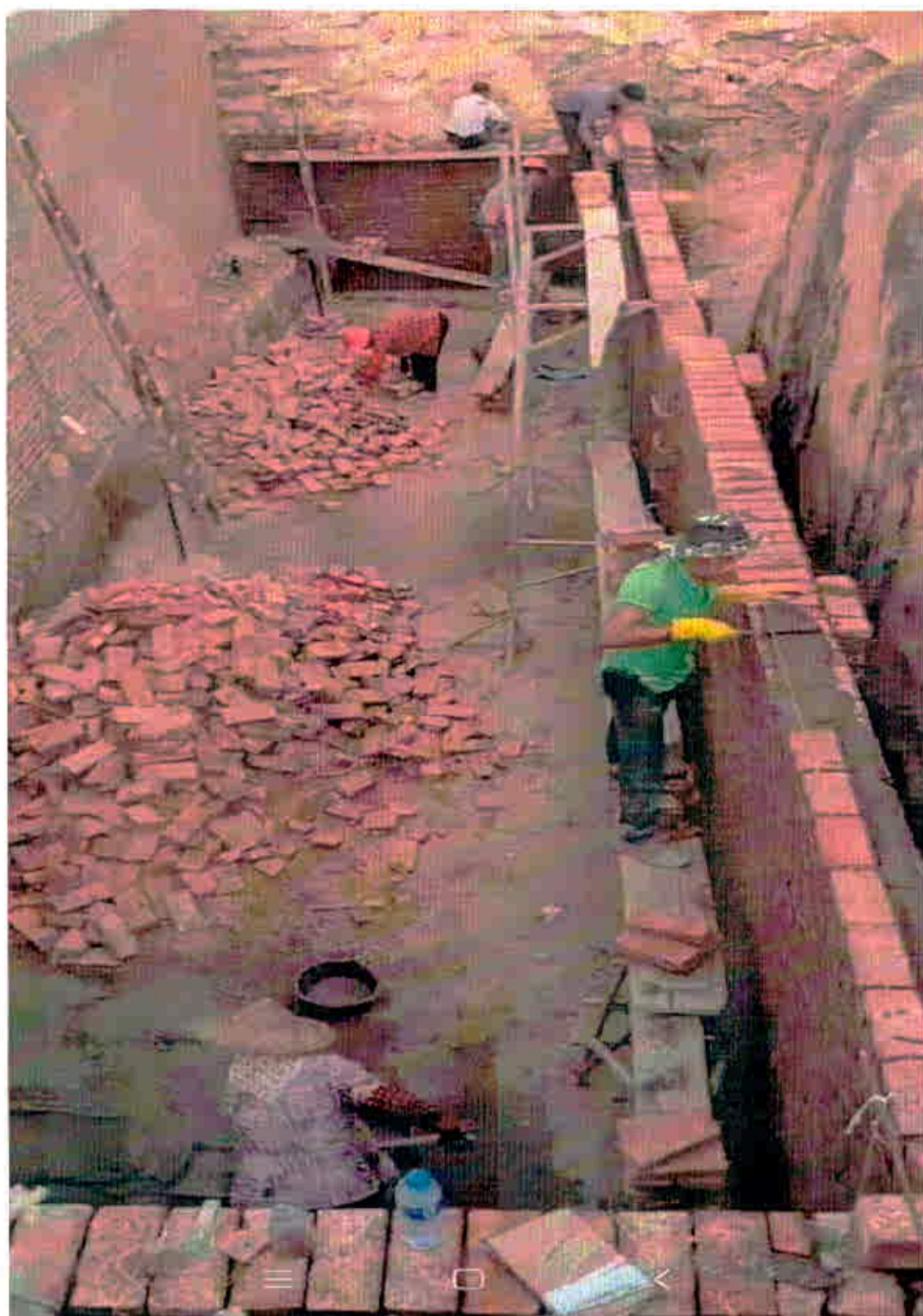
说明：6月10日17时30分时事故水池的施工情况。
