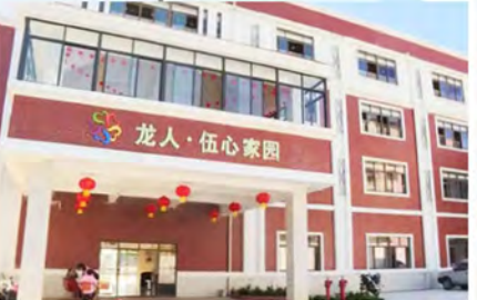
湄洲湾 XZ-JG-06 泉港区中心敬老院
